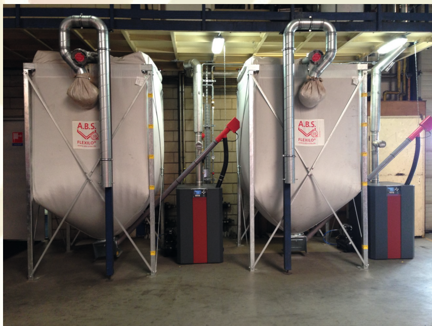
Twee stuks 30 kW RTB houtpelletketels in cascade, met elk een eigen zaksilo te Biddinghuizen.
